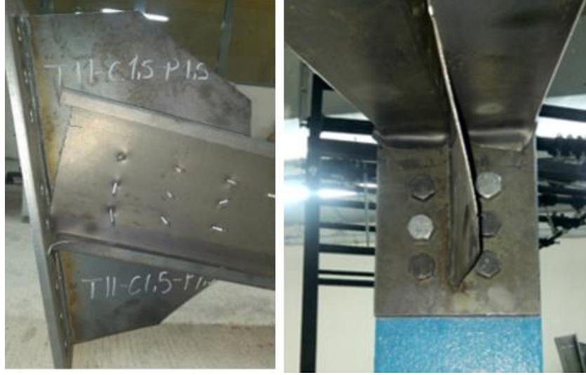
Şekil 18. T11-C1,5-P1,5 Numunesinin göçme şekilleri
