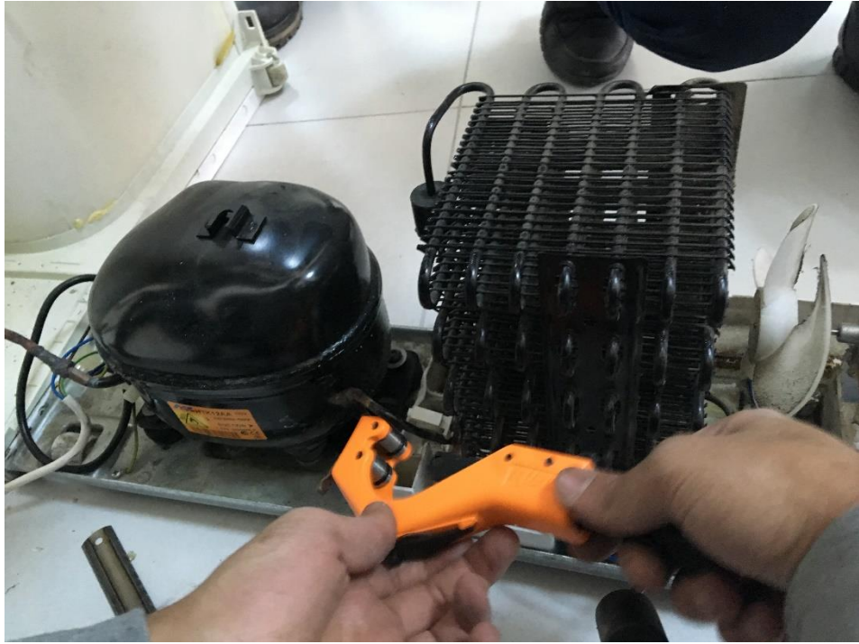
Şekil 3. Buzdolabının kompresör ve yoğuşturucu elemanları
